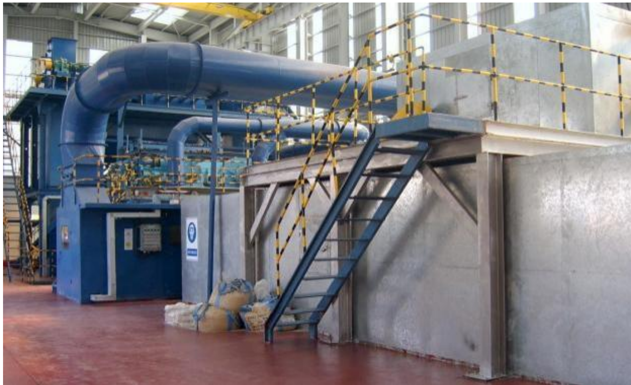
钢材预处理线（4.5m 宽，6m/min ）烘干系统
