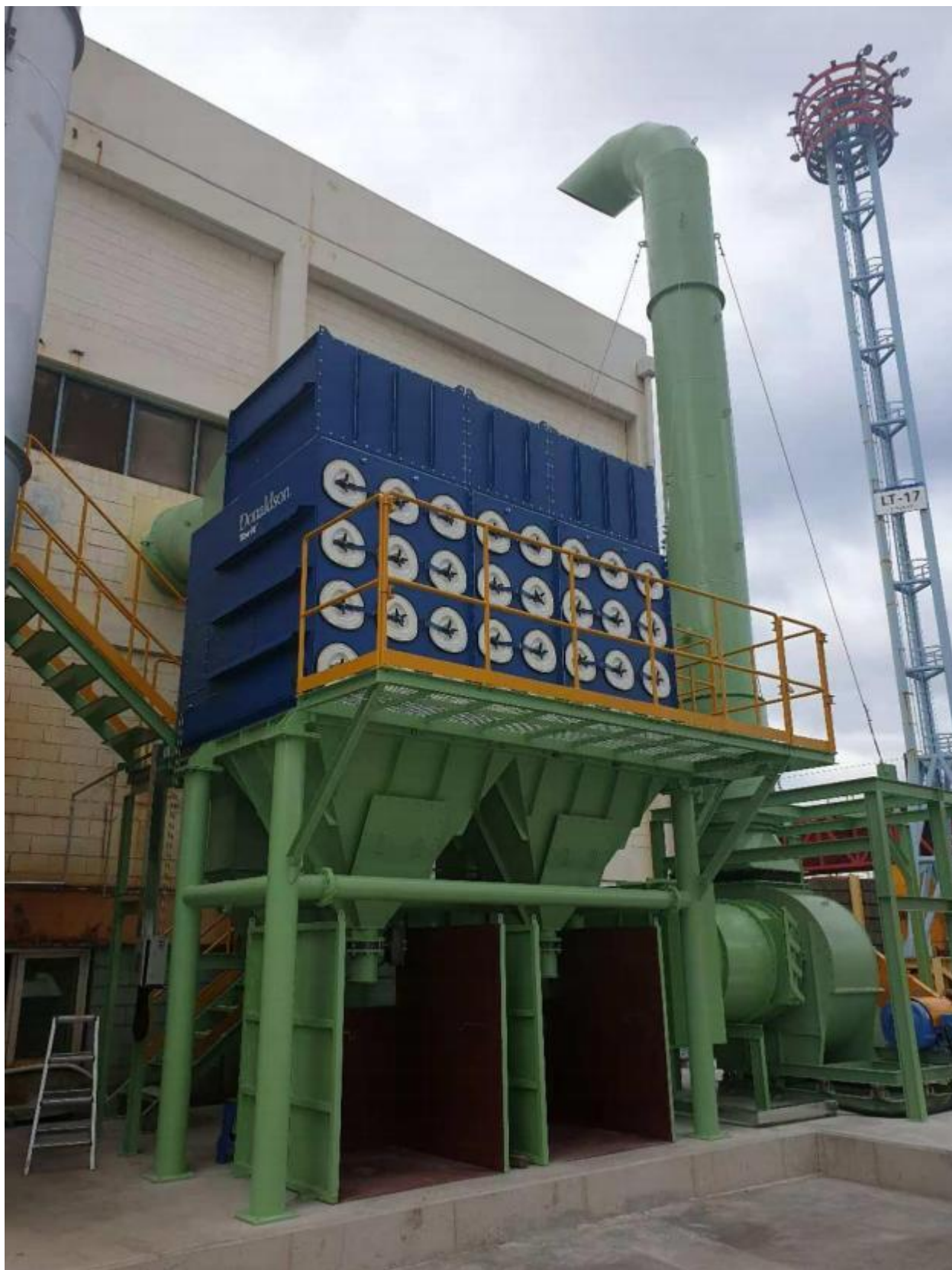
钢材预处理线（4.5m 宽，6m/min ）除尘系统
