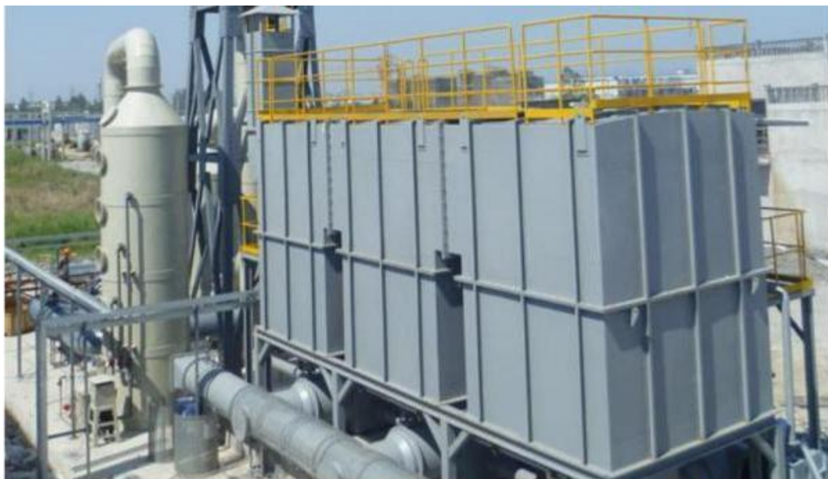
钢材预处理线（4.5m 宽，6m/min ）RT0 系统
